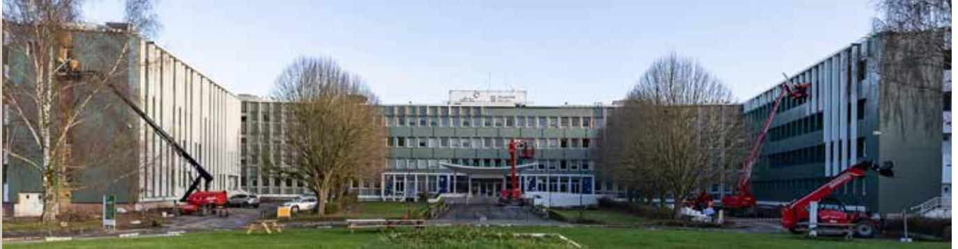
La nouvelle façade reprend les codes des façades d'origine. La trame verticale créée par les trumeaux structurels en béton est revisitée par de grandes lames en aluminium de teinte blanche, plus fines et de profondeur variable.
